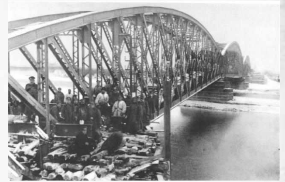
Восстановление моста через реку Днестр
