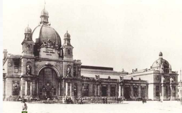
Пассажирское здание станции Львов-центральный
