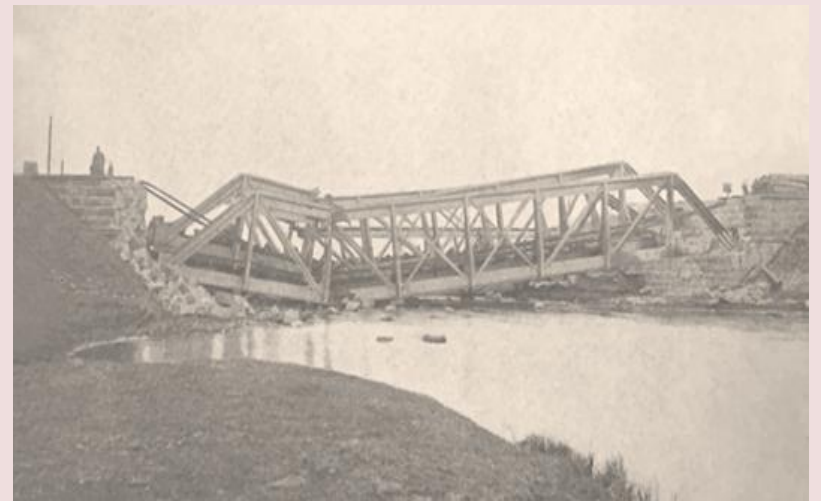
Взорванный немцами мост на 115 версте главной линии (1915 г.)
