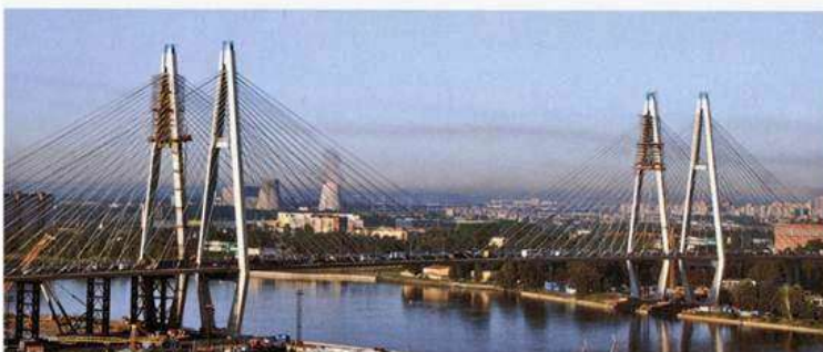
Большой Обуховский мост через реку Неву
