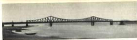
Рис. 66. Старый мост через р. Реба
