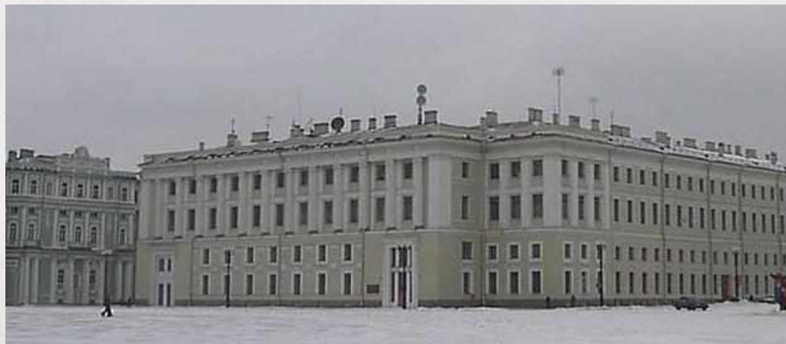
Здание Штаба Гвардейского корпуса
