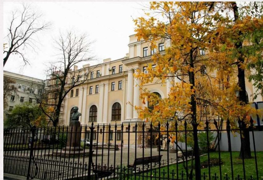
Современный вид больницы
