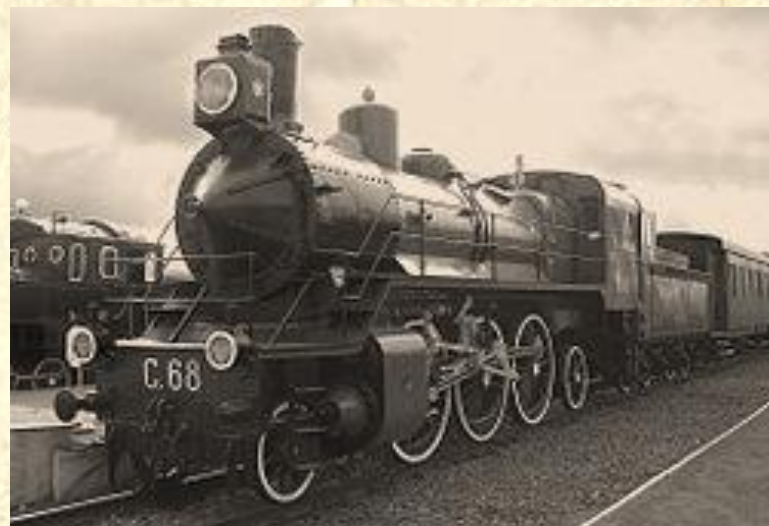
Паровоз серии С типа 1-3-1
