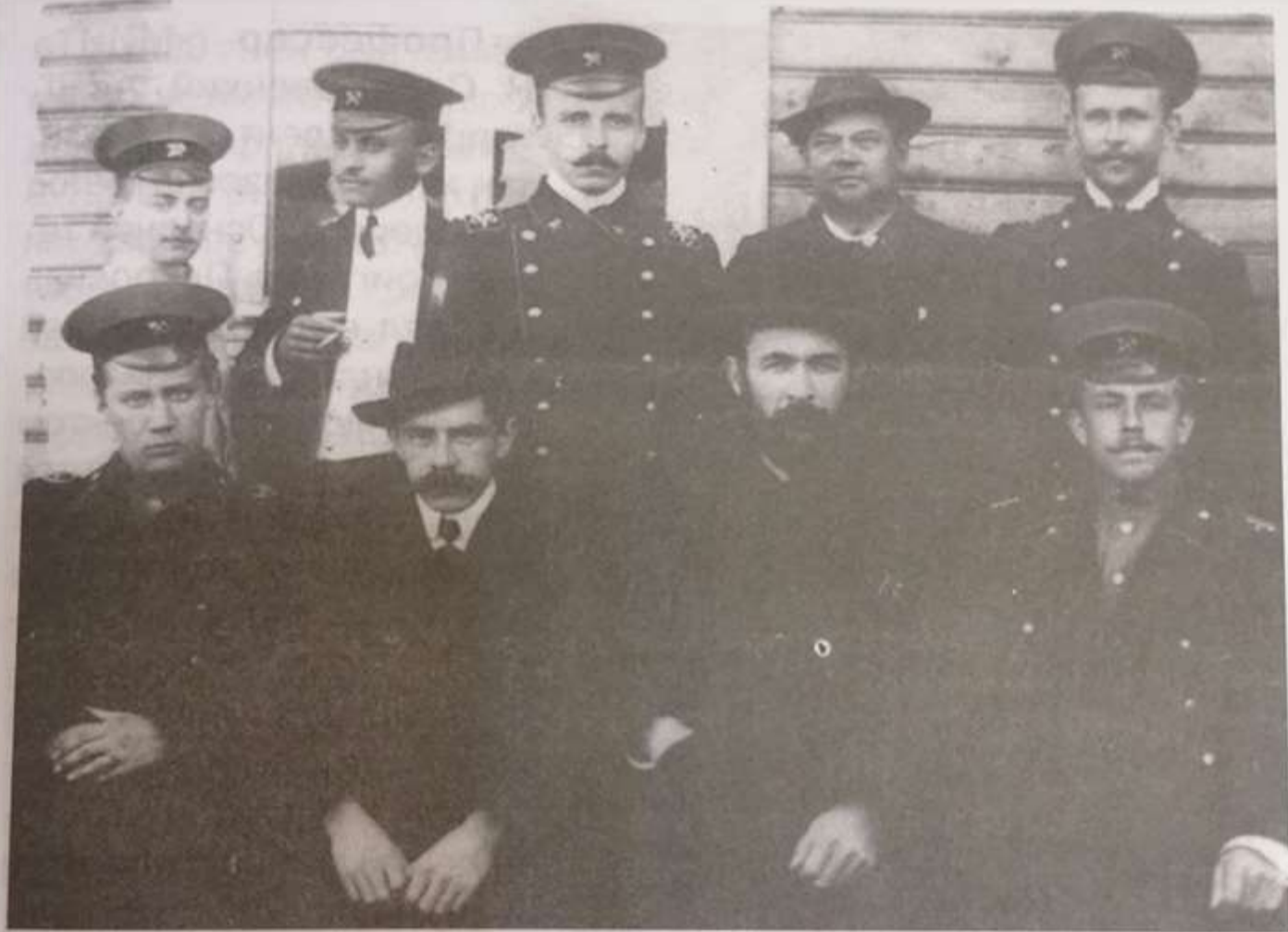
Г. П. Передерий со студентами-практиками на строительстве Большеохтинского моста
