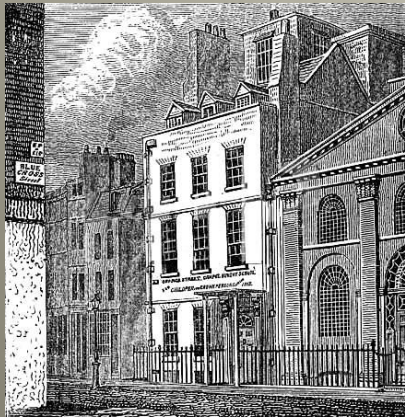
Дом в Лондоне, где жил Ньютон.
