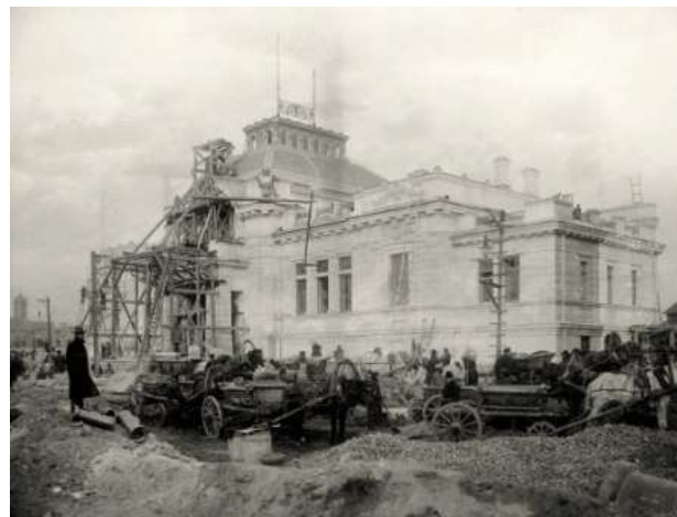
Строительство Императорского павильона в Санкт-Петербурге, 1901 г. Здание сохранилось до наших дней - Загородный проспект, 52Б.
