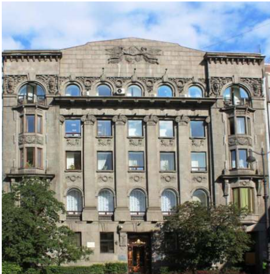
Здание Петербургского управления Общества Московско-Виндаво- Рыбинской железной дороги. Санкт-Петербург, пл. Островского.
