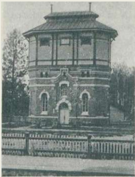
Водоемное здание на 2 бака
