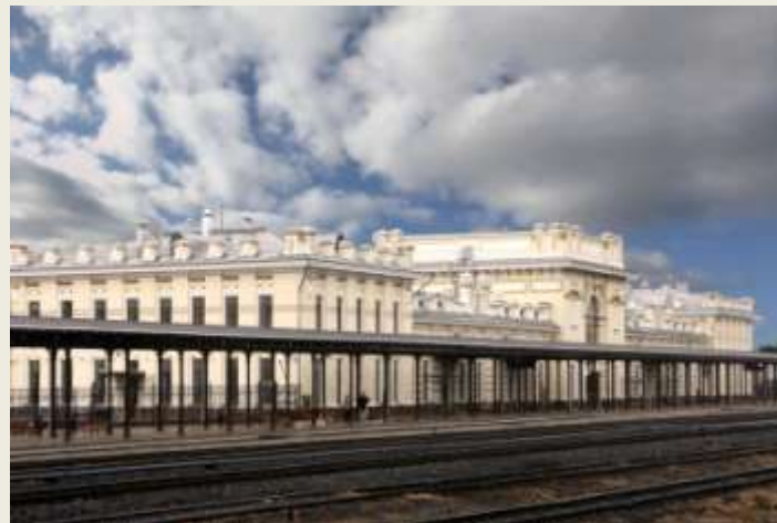
Современный вокзал был возведен в 1904-1905 гг. в стиле модерн. Вокзал был центром городской светской жизни, где проходили балы, устраивали концерты и званые вечера.
