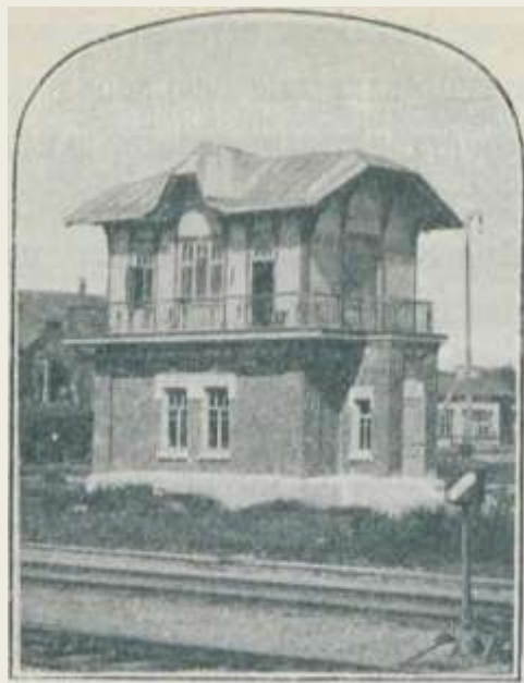
Будка центрального управления стрелками
