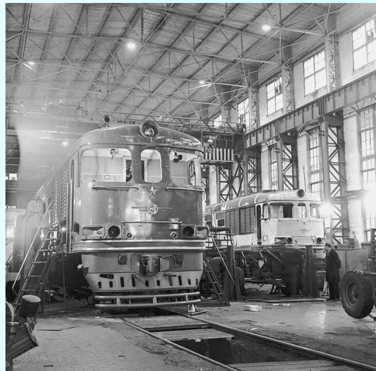
Сборочный цех Коломенского завода 2020 г.
