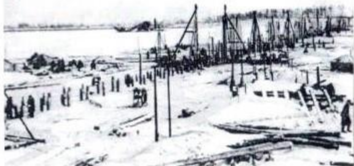
Строительство низководного свайно-ледового моста через р. Неву у Шлиссельбурга в январе 1943 г.
